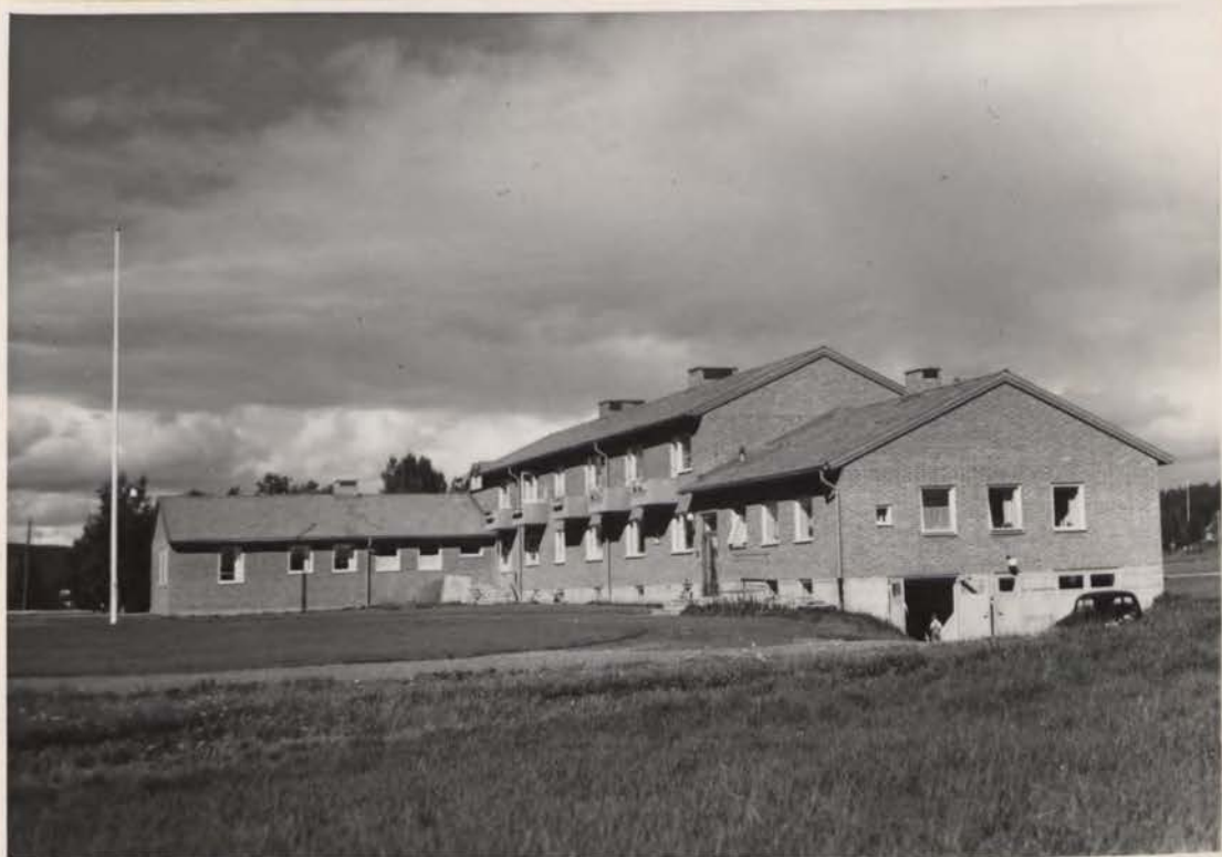
Klinikbyggnad i Svenstavik (Tandklinik, förlossningsavd., arbetsförmedl., kommunalkontor, m.m.)
