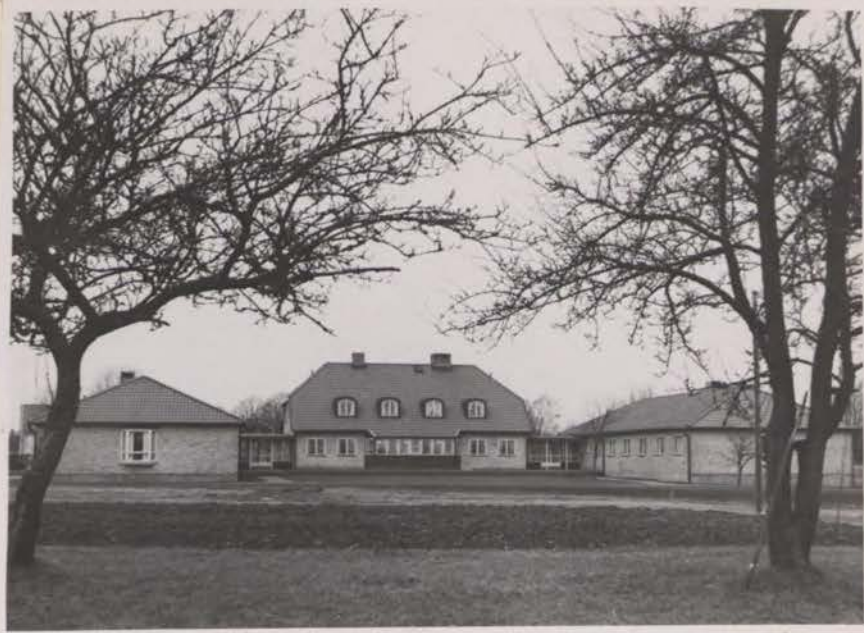
Följer vi Mörrumsån genom kommunen kommer vi till Gemla och här möter oss nya tiden. Här har kommunen uppfört sitt vackra ålderdomshem, som togs i bruk 1954.
