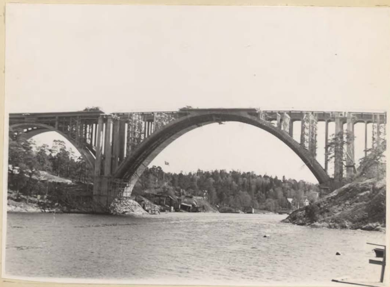
Skurubron leder till Boo kommun och Värmdön. den är nu under till- och ombyggnad
