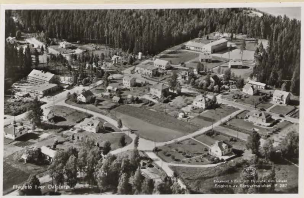
Dalstörps samhälle med kommunal- huset under uppförande.
