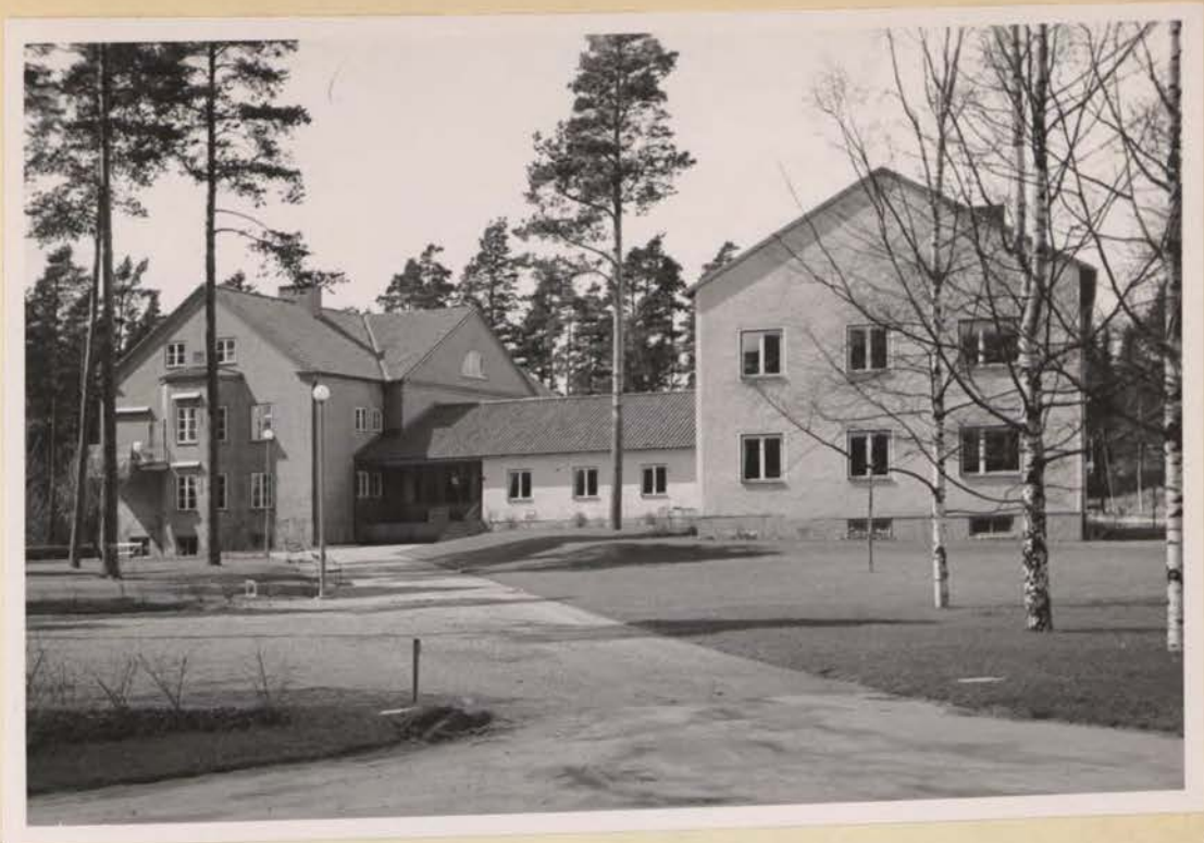
Ålderdomshem med tillbyggnad. Den äldre byggnaden till vänster & bilden uppfördes år 1924 och tillbyggnaden, mittenpartiet samt högra delen av byggnadskroppen år 1954.
