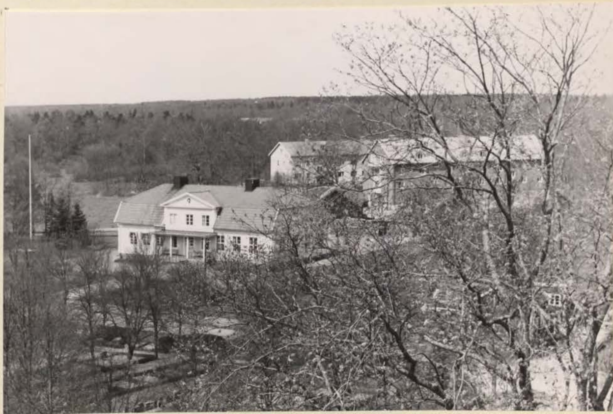
Kommunalhuset med kommunalt hyreshus och pensionärshem i bakgrunden.
