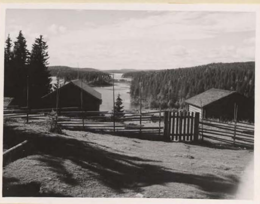
Linsta fäbod vid Linstasjön, Färila
