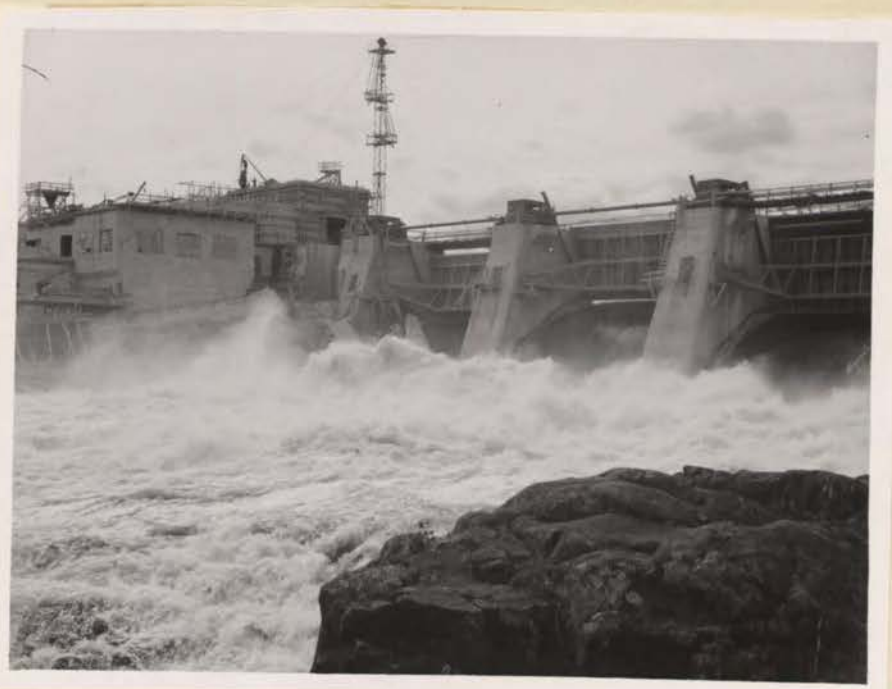
Laforsens kraftstation under utbyggnaden
