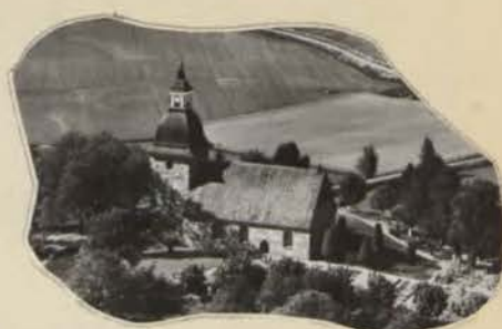
Törnsfalls kyrka, en av traktens äldsta.
