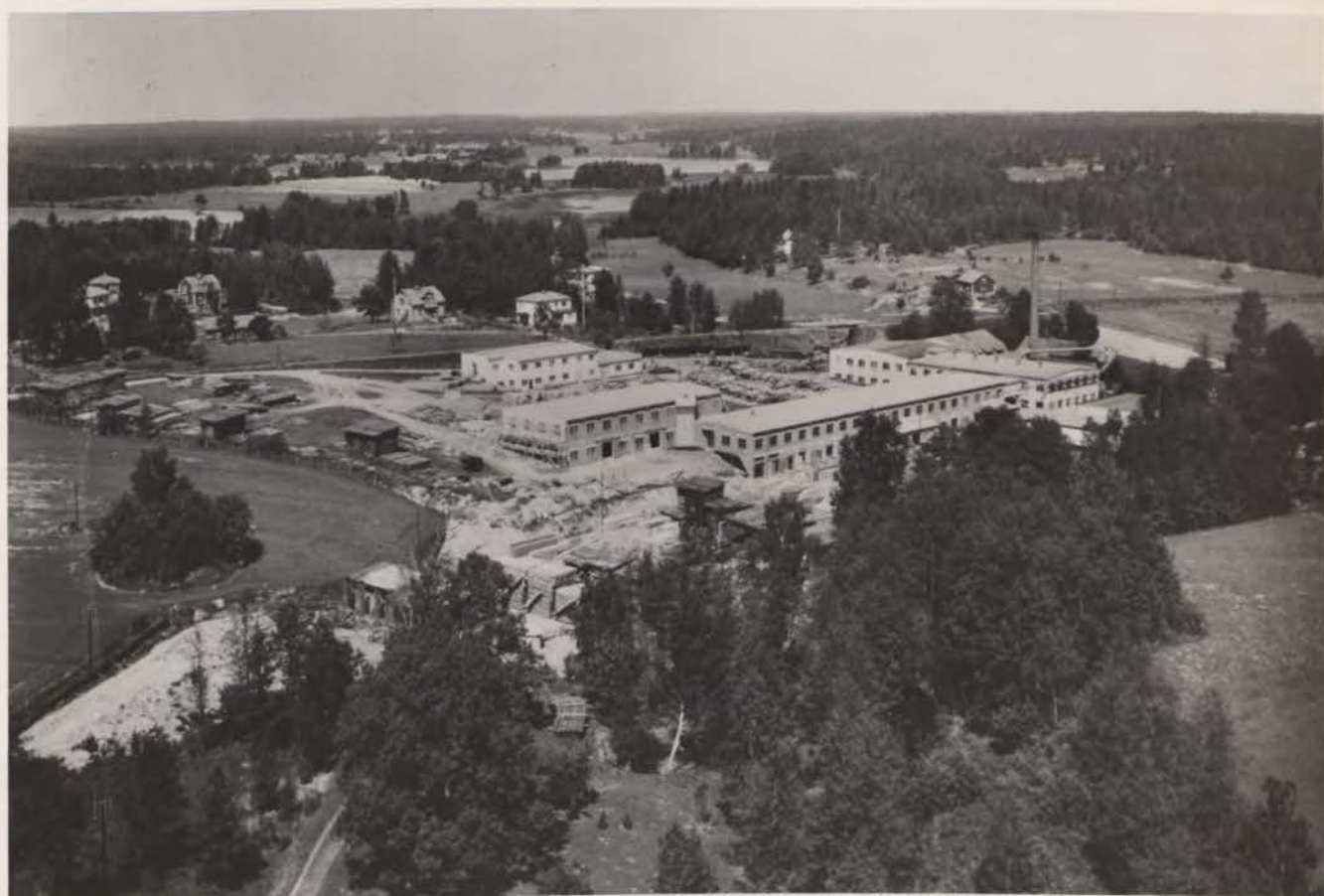
Flygfoto över AB Totebo Industriens anläggningar.
