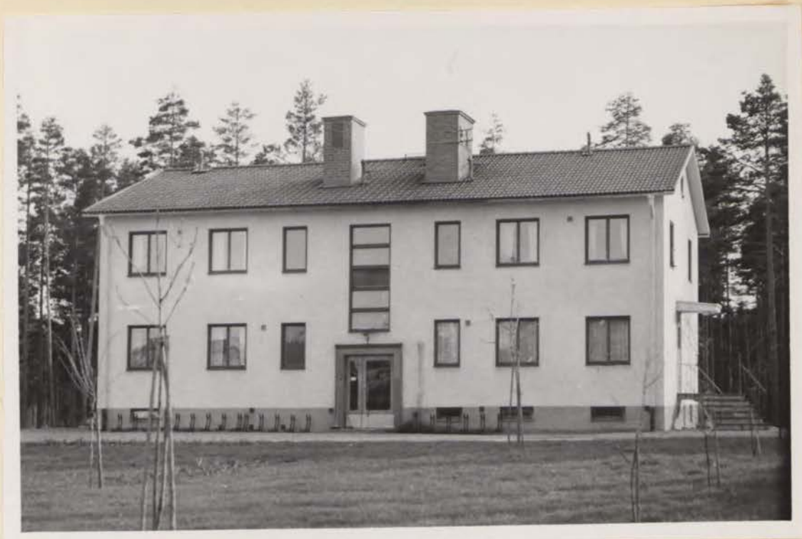
Byggnad inrymmande lokaler för läkarmottagning m.m. uppförd år 1948.
