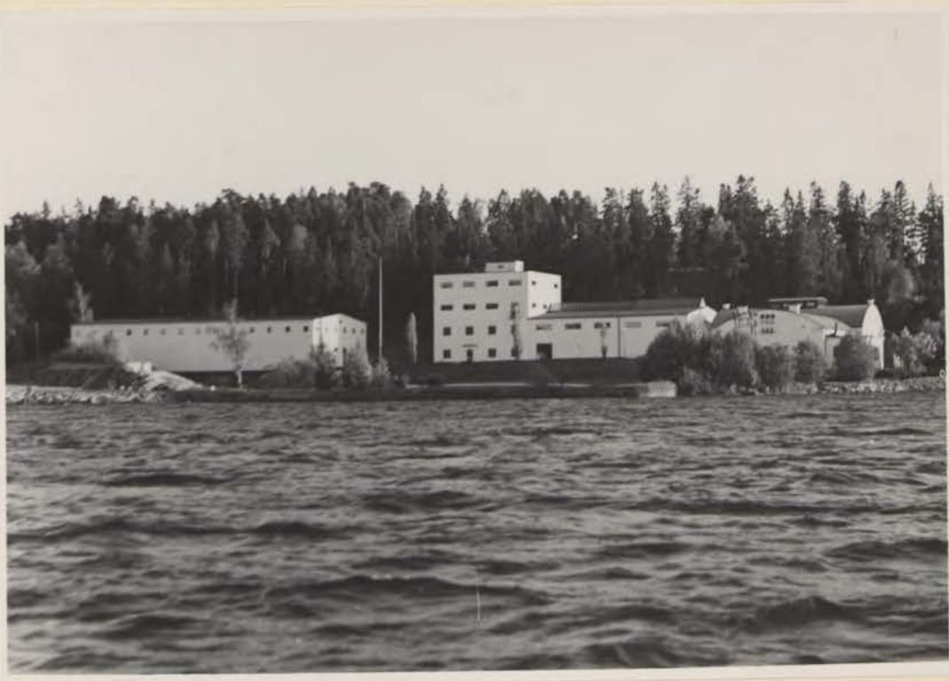
Stockholms norra förorters vattenverk på Skäftingeholmen, anlagt år 1929, utvidgat åren 1940-42.
