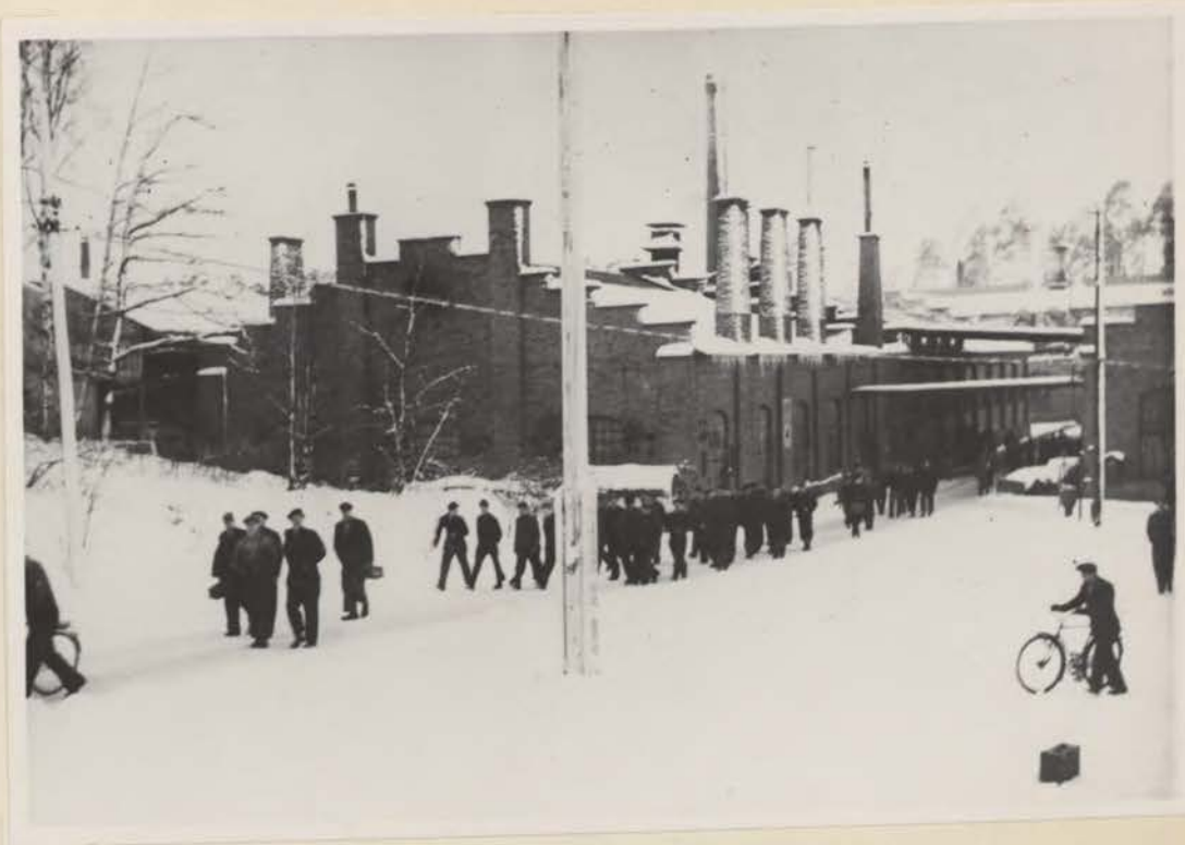
Bolinders Fabriks AB:s verkstäder i Kallhäll anlades 1907, och har senare utvidgats i flera etapper.
