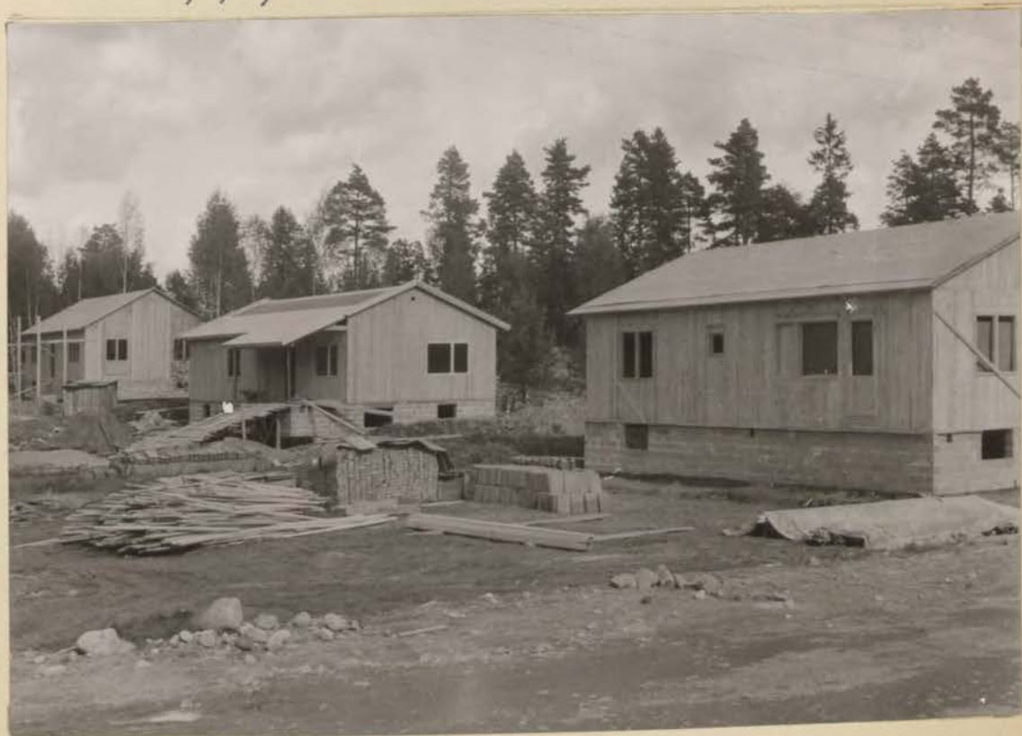
Alvägen, Järna. Egnahem under uppförande 1954.
