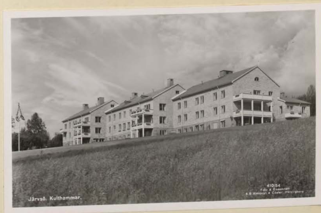
Ålderdomshemmet. Togs i bruk 15/12 1952. 51 vårdplatser + bostäder åt husmor och 10 bitr. Byggn. kostnad 900.000 Arkitekt Hj. Hammarling, Stockholm.
