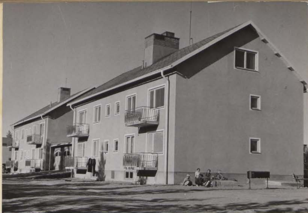
Hyrarhus byggt av kommunal bostadsstiftelse 1953
