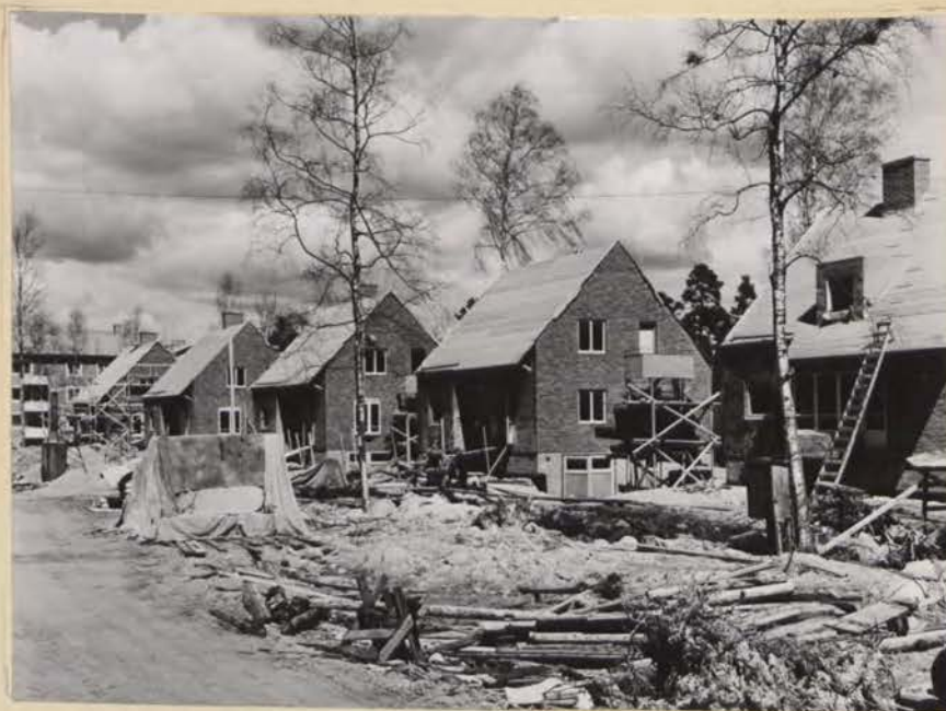
Egnahemsbebyggelse inom det nya stadsplanerade området Södra Skogen, där sammanlagt c:a 1.700 personer beräknas kunna inrymmas.
