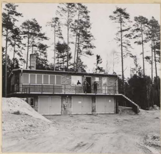
Nya sopstationen, uppförd 1954
