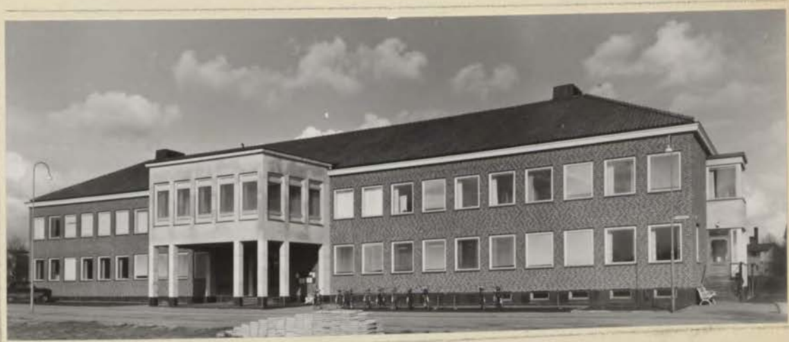
Nya kommunalhuset, inrymmande lokaler för kommunalkontor, byggnadskontor, sessionssal och sammanträdesrum, pastorsexpedition, poliskontor, landsfiskalskontor, sjukkassa, arbetsförmedling och civilförsvarscentral.
