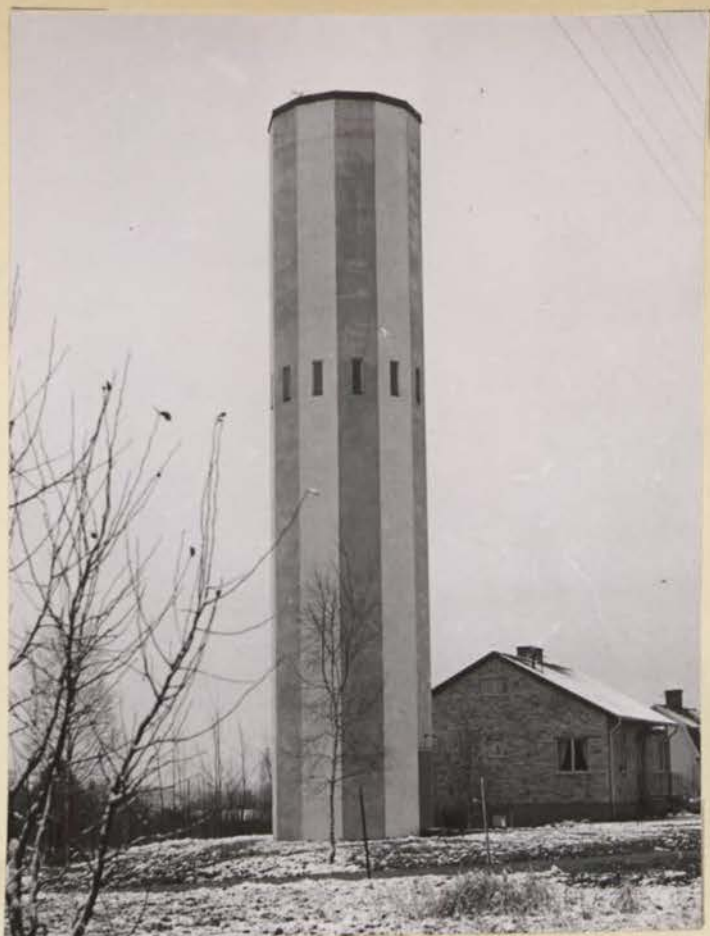
Vattentornet i Åbytorp är ett av de få ovan jord synliga bevisen på att kommunen lagt ned - även i bokstavlig bemärkelse - över en million kronor i vatten och avlopp.
