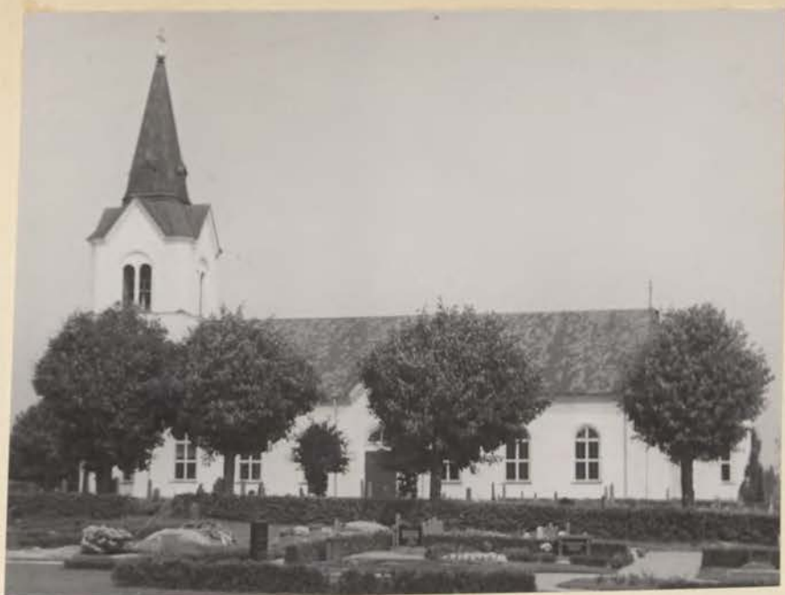
Styckelunds kyrka byggd 1865.
