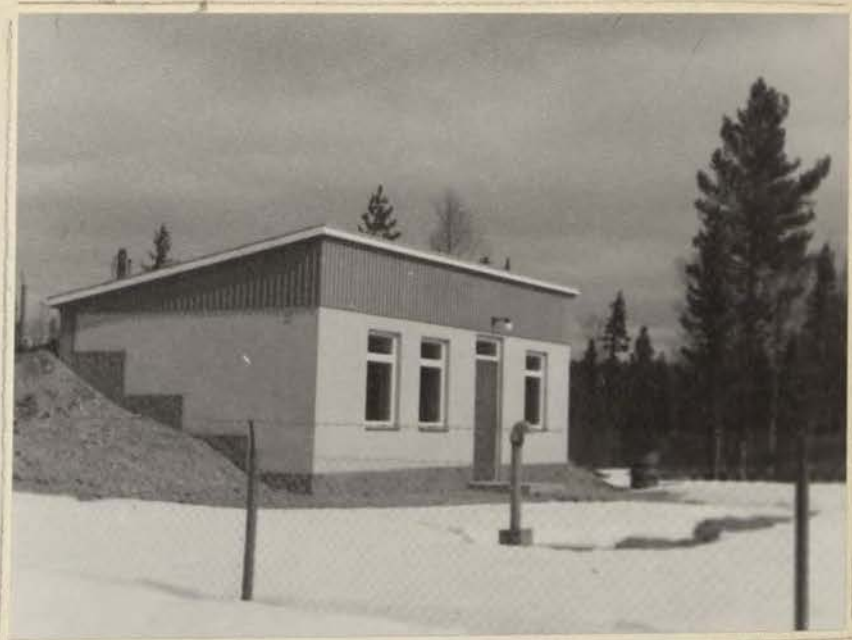
Kälarne Vattenverk, från vilket källvatten uppumpas och levereras till c:a 125 fastigheter inom Kälarne stationssamhälle. (hittills invest.kostn.inkl.reningsverk 1.2 milj. kronor)
