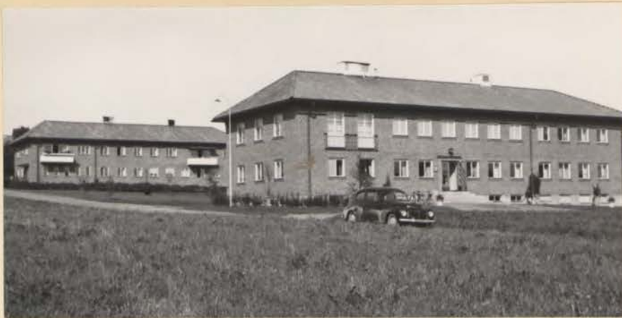
Förvaltningsbyggnad och läkarmottagning m.m. i Lits stations- samhälle.
