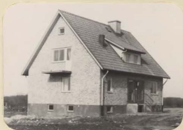
Under det gångna året har byggts en ny, fin distriktssköterskebostad med läkarmottagning.
