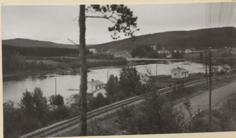
Sommaren i sitt flor, den vackra, men tånjda, Faxälven. I bakgrunden syns en del av Hjalta kraftverk - 100 milj.
