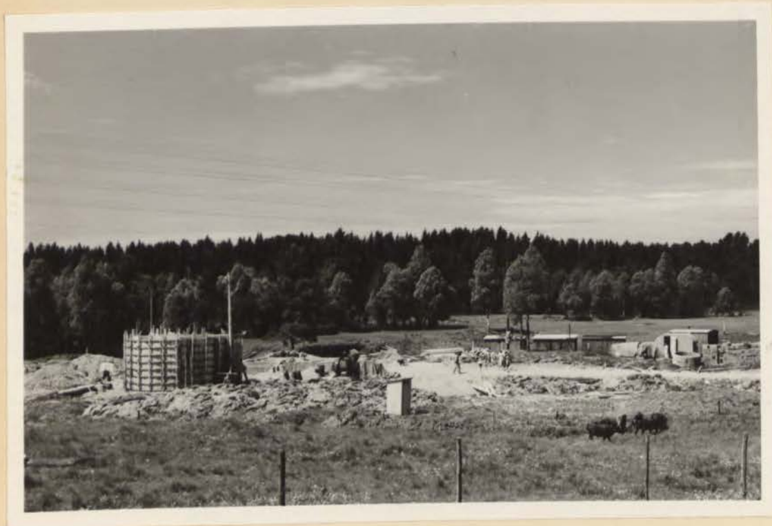
Byggnadsarbete å vattentäkt för Malmbäcks samhälle.
