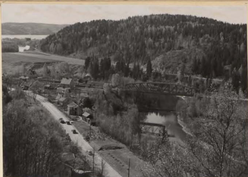
Järnvägsbro på sträckan Saltkällan - Munkedal.
