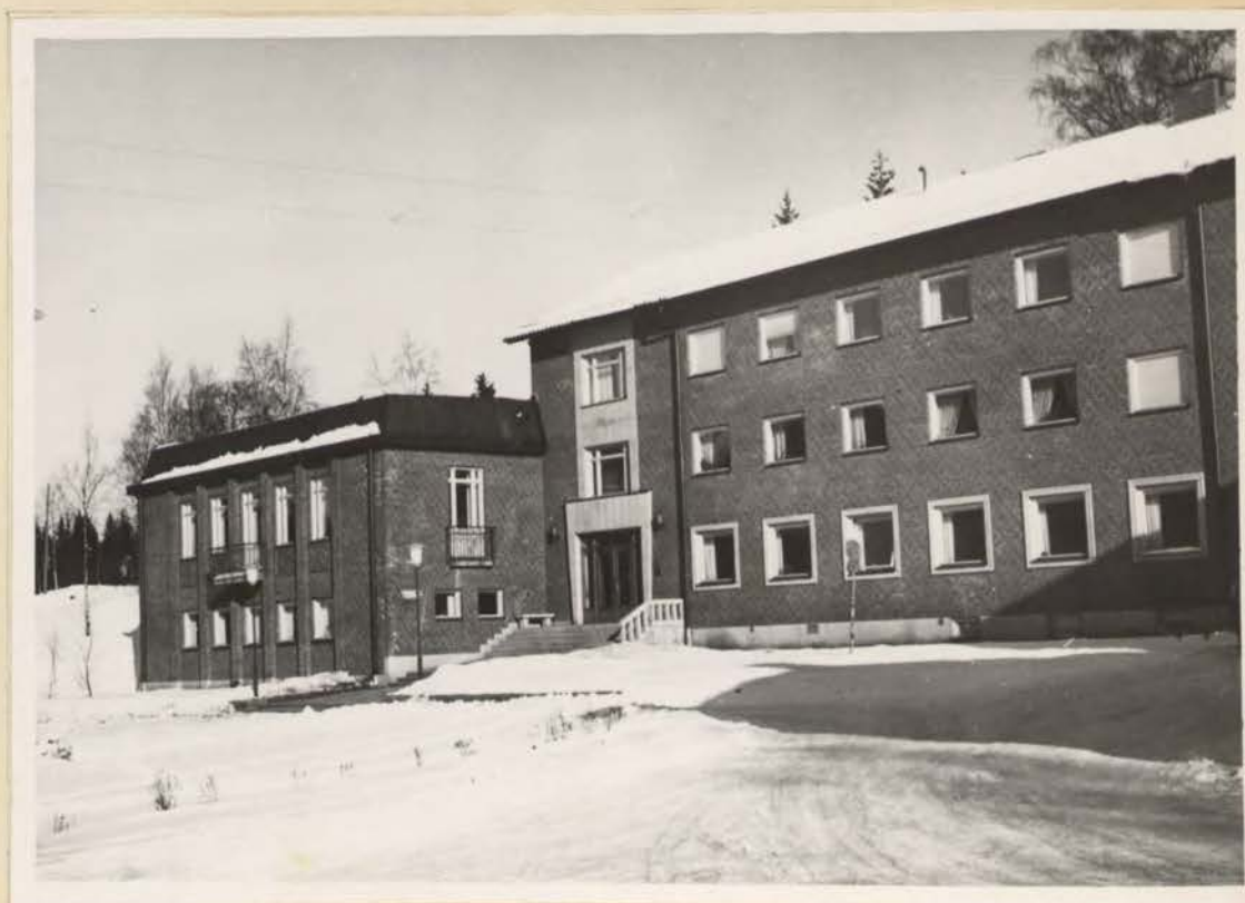
Exteriör av Måsarps kommunalhus.
