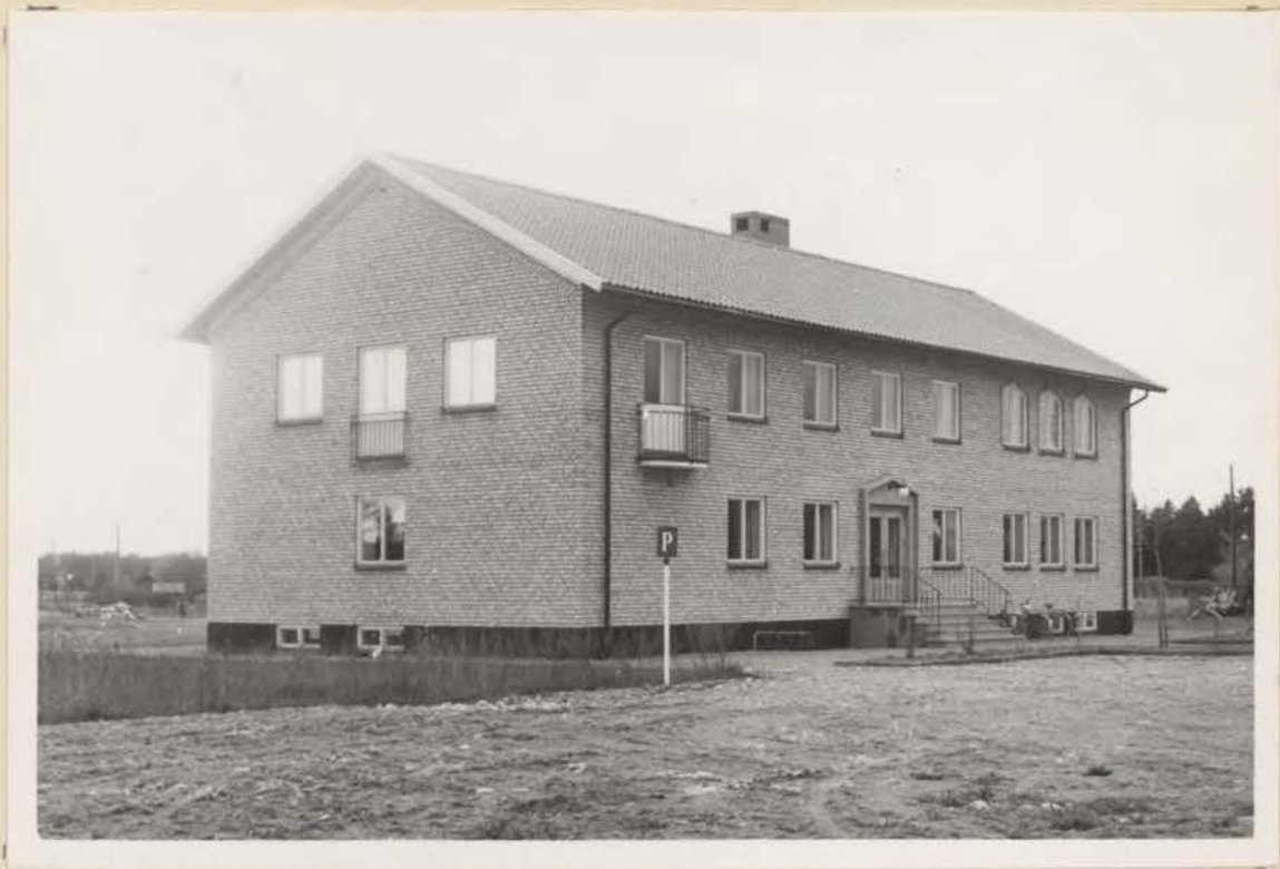
Mörbylånga kommunalhus, uppfört åren 1952—1953.
