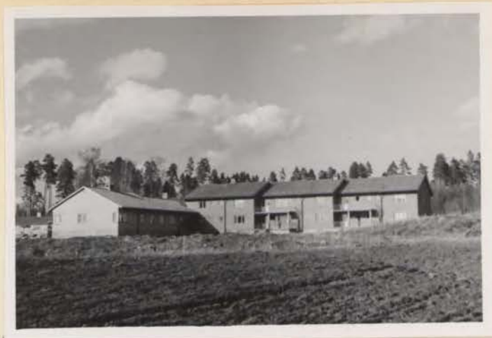
Ramnäs nya ålderdomshem har plats för 30 pensionärer och invigdes i april 1955.
