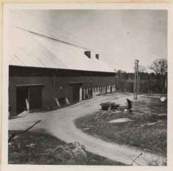
Ekonomibyggnad Bergby gård Riala.
