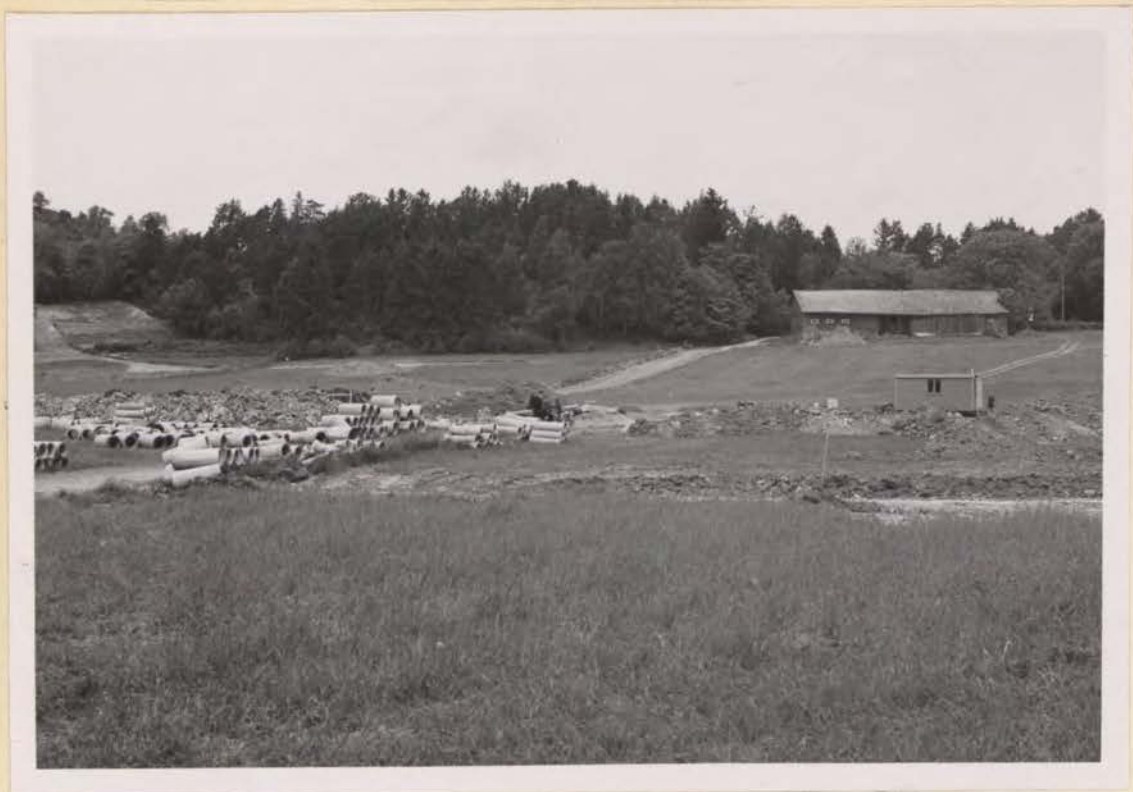
Exploateringsområde för 154 egnahem beläget 3 km norr Uddevalla, färdigt september 1955.
