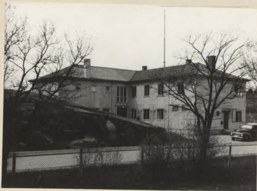
Kommunalhuset i vilket inrymmer kommunalkontor, sammanträdesrum, folktandvårdspoliklinik, polis-kontor, brandstation, arkiv och bibliotekslokal samt en lägenhet.
