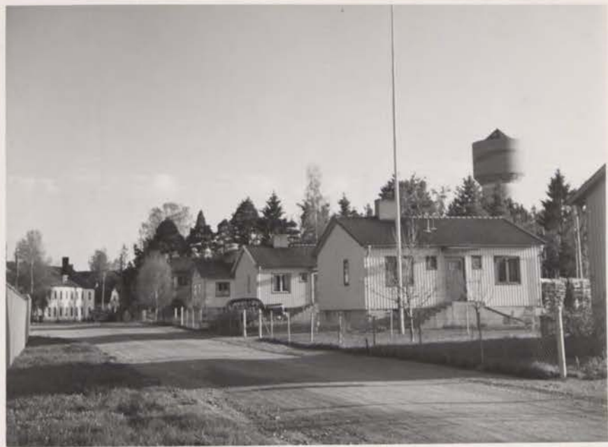
Bostadsbyggandet är för närvarande rekordartat. På senare år har uppförts mest flerfamiljshus. Tidigare övervägande egnahem - de flesta i grannskapet av arbetsplatsen.
