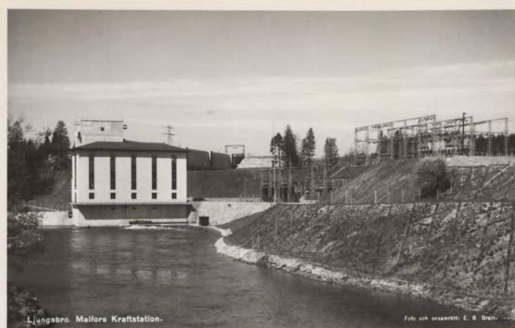
Malfors kraftstation, Ljungbro. Effekt: 20000 kW:s Invigdes 1936. Ägare: Svenska Staten.
