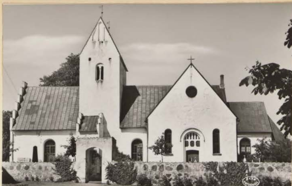
Köpinge kyrka inom tidigare Gärds Köpinge kommun, vilken ingår i nuvarande Vä kommun, byggd under elvahundratalet.
