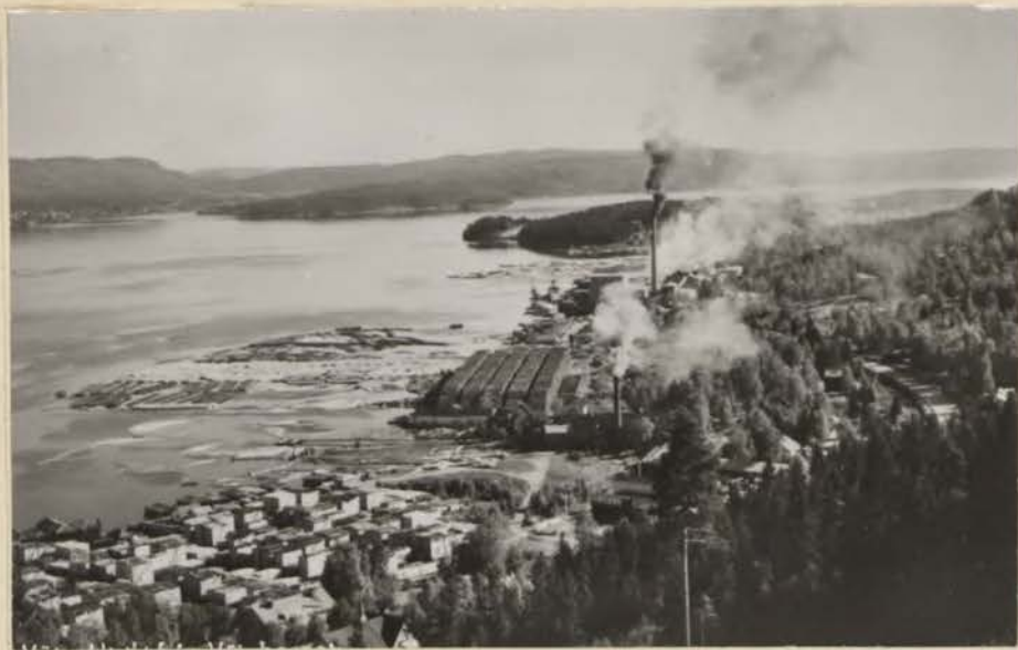
Pappersmassfabriken i Väja och sågverket
