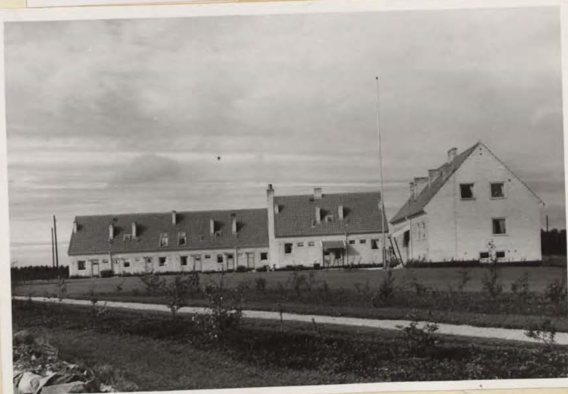
Östra Frosta Pensionärshem, beläget i Osbyholm och uppfört 1953, innehåller 17 pensionärslägenheter och tjänstebostäder för distriktskyöterska och hemsyster.
