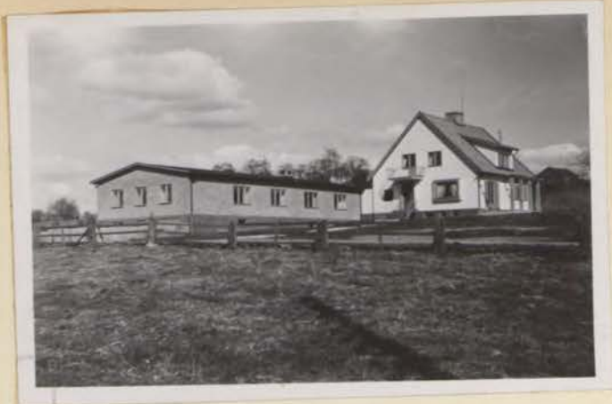
Mottagningslokaler för provins- sialläkare, mödra- och barna- vårdsstation, distriktssköterske- expedition och förbandscentral för civilförsvaret.
